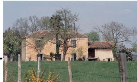
Au Sud-Est des Landes, dans le Tursan, l'influence des maisons béarnaises se traduit par la forme à 4 eaux, couverte de tuiles plates à crochets (tuiles picon), et par le raidissement des toitures. En bas de pente, un coyau vient infléchir l'inclinaison du toit. La composition reste classique dans l'alignement équilibré des ouvertures (fenêtres et lucarnes). La pierre et le galet, protégés par un crépi gris, rappellent les origines pyrénéennes de cette architecture.
